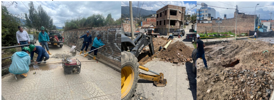
Ilustración 5. Obras concertadas con Infraestructura
