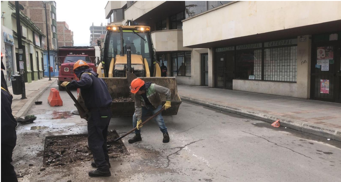
Ilustración 33 Trabajos realizados en la ejecución del Contrato de obra C42023005
