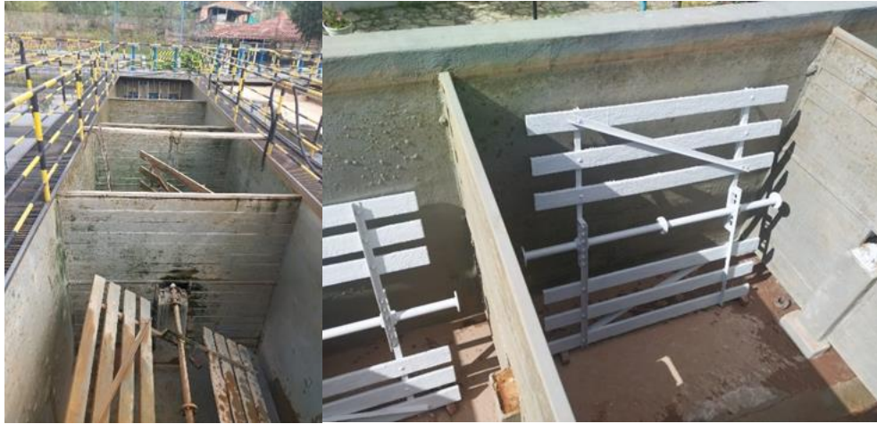
Ilustración 66 limpieza y pintura de aspas en material epóxido
