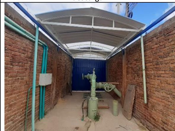
FOTO 19. Tubería de descarga después del mantenimiento y cubierta nueva
