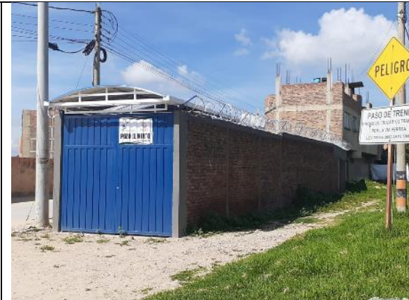
FOTO 22. Estado exterior pozo mirto después del mantenimiento locativo
