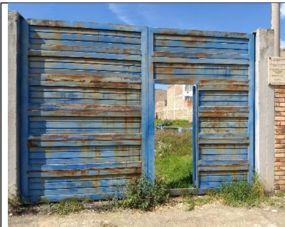
FOTO 23. Portón principal pozo bosque antes del mantenimiento de pintura
