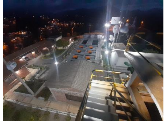
FOTO 6. Planta milagrosa después del mantenimiento de alumbrado exterior
