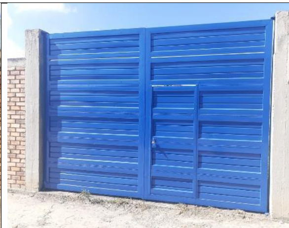
FOTO 24. Estado exterior portón después del mantenimiento de pintura
