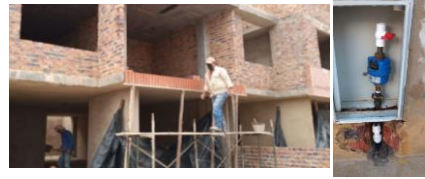
Construcción directa con fuga y sin medidor, usuario tiene legalizado el servicio, por tal razón, se solicita el medidor y se deja instalado.
