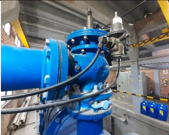
FOTO 11. Mantenimiento a la válvula anticipadora golpe ariete 6"
