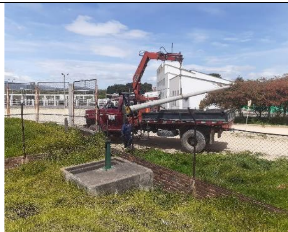
FOTO 14. Montaje poste para reflector solar en bocatoma Chicamocha
