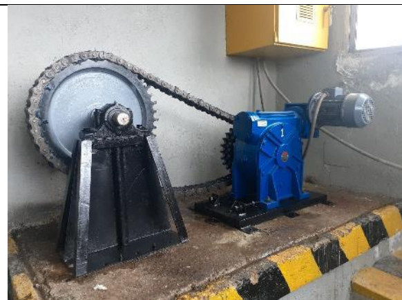
FOTO 2. Motorreductor después del mantenimiento
