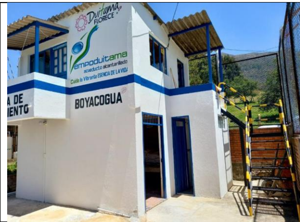
FOTO 10. Mantenimiento locativo sala de operaciones y escalera acceso
