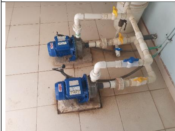
FOTO 3. Mantenimiento bombas sistema cloración
