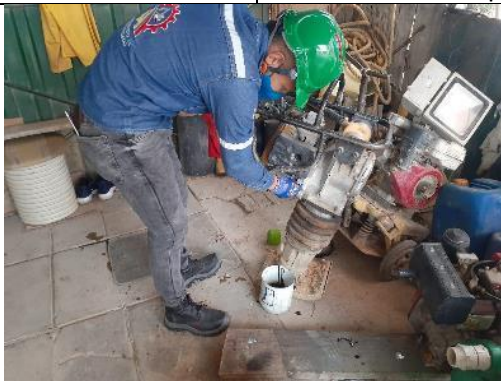
FOTO 29. Cambio de aceite en equipos existentes
