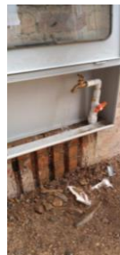
Construcción ubicada en la C 13 # 32 - 24, directa sin medidor, queda suspendido. Usuario legalizó servicio
