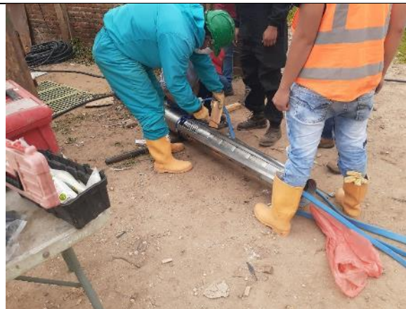
FOTO 18. Conexión bomba nueva tipo lápiz de 125 HP
