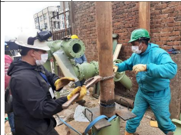
FOTO 17. Actividades de montaje tubería de descarga
